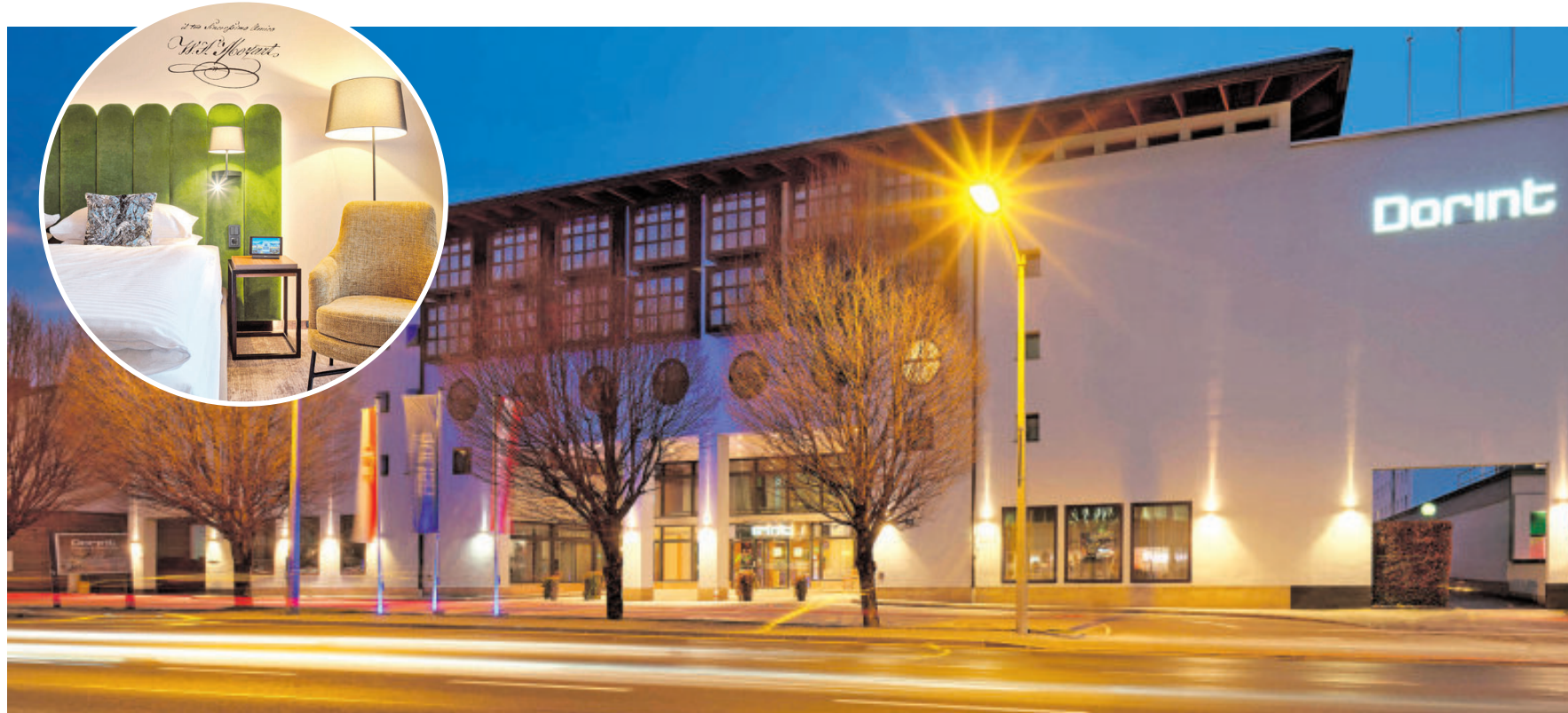
Das Dorint wird im Inneren umgestaltet und will sich mit Restaurant und Bar samt Garten für das Salzburger Publikum öffnen. Das kleine Bild zeigt den Blick in ein renoviertes Zimmer. BILD: SN/DORINT/SO-ENNE-ARCHITEKURFOTOGRAF
