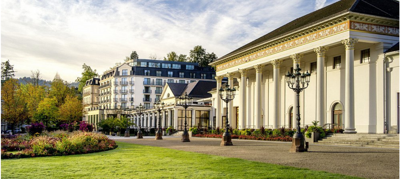
Eines der Flaggschiffe der Dorint-Kette: Das Maison Messmer in Baden Baden soll Teil der neuen „Hommage-Kollektion“ werden. | © POCHA-BURWITZ
